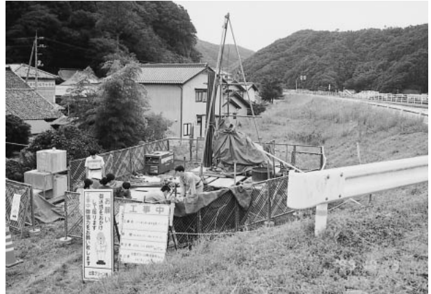
写真1 江の川の右岸堤防(市村)におけるボーリング
