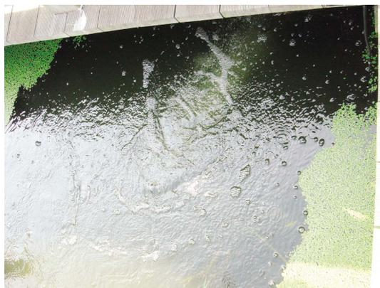
写真10：N池で稼働する微細気泡の様子
