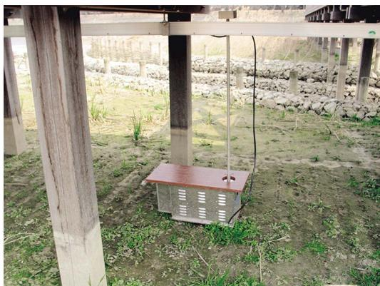
写真9：N池で用いたE社の微細気泡発生器
