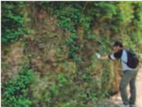
図 5. 津田岩体露頭写真：風化が進んだ露頭状況。
