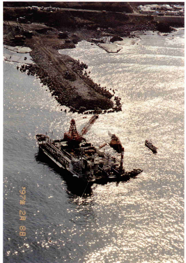
写真5 ヘリコプターから見たナホトカ号の船首部分(中央の小さい船体)からの重油の抜き取り作業とはしけの埋め立て工事(上部の細長い道路)(福井県三国町安東 1997.2.8. 撮影).
