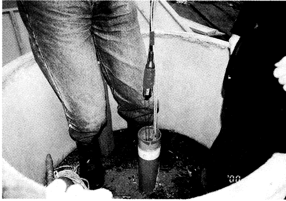
写真1 観測用に仕上げられたボーリング孔と水位センサ
