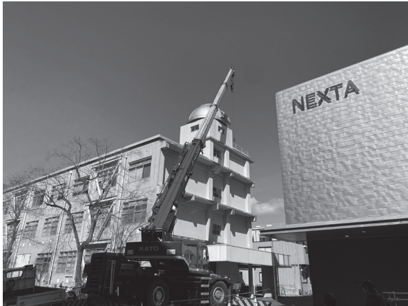
クレーンによる移設作業の様子 (R8.3.17)
