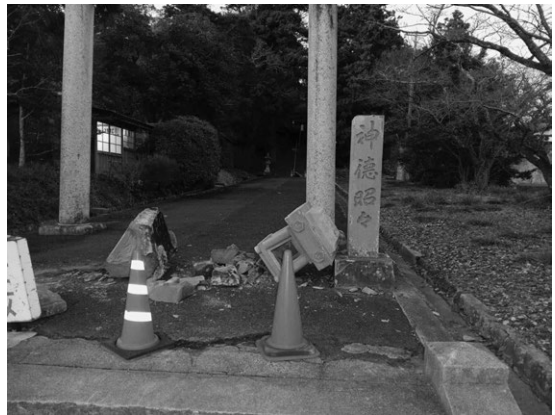
図 3 松江市竹矢町，平濱八幡宮・武内神社境内における石灯籠の倒壊
