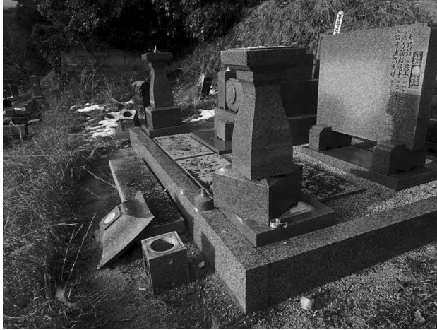
図7 安来市広瀬町宇波の墓地における墓前灯籠の倒壊事例(左), およびこの墓地における石造物倒壊方向のローズダイアグラム(右). 矢印は平均方位, 網掛け部は標準偏差(1σ)を示す
