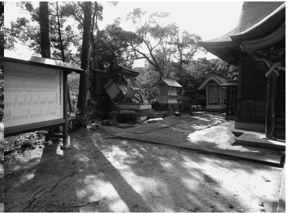
図6 安来市広瀬町下山佐，山狭神社における石灯籠の倒壊事例（左）と境内社の転倒（右）
