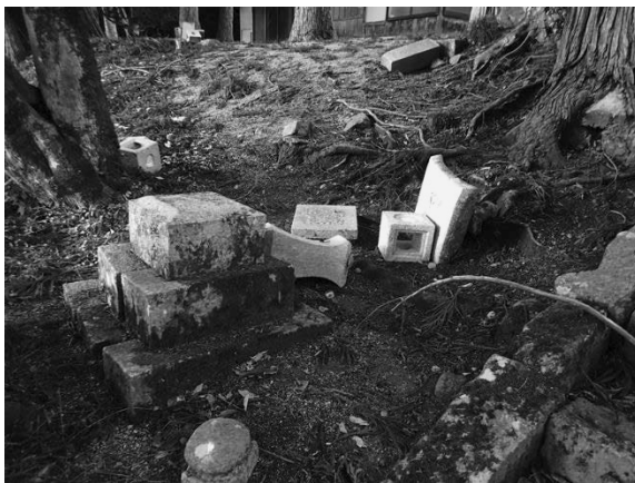
図9 安来市広瀬町宇波の宇波神社における石灯籠の倒壊事例(左), および宇波神社境内における石造物倒壊方向のローズダイアグラム(右). 矢印は平均方位, 網掛け部は標準偏差(1σ)を示す
