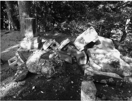
図6 安来市広瀬町下山佐，山狭神社における石灯籠の倒壊事例（左）と境内社の転倒（右）
