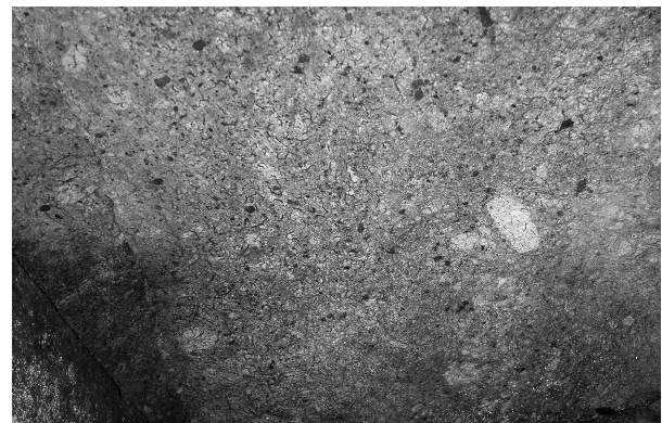
第42図 玄室天井石の状況
