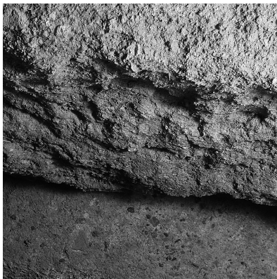
1. ノミ敲打技法 (廻原1号墳玄室天井石南小口)
