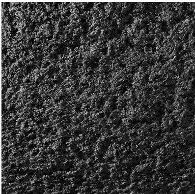
16. 小叩き技法 (石宝殿古墳石槨左側壁内面)
