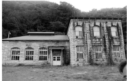
山陰電気 旧・江尾水力発電所 (1,000kW、1919年竣工) (2016年10月撮影)
