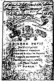
▲写真に添付された広告名刺。 (訳) フランス各教会・各学校・医学校御用達。写真師 エール・プティ・パリ、カデ ット広場。ラロックより。 塩野門之助様へ。愛憎に満ちた思い出を持ちつつ、 1881年8月28日パリにて 写す。)
