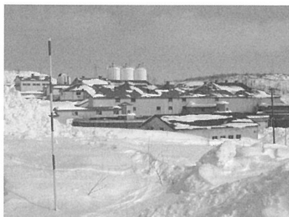
写真1：坑廃水処理施設の全景（2009年2月、関撮影）
