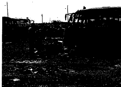
写真6 大型車（バス）の解体作業。
