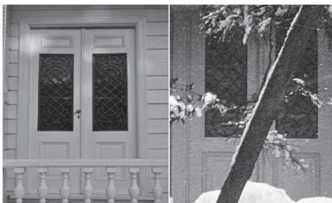
平屋時代の古写真(右上) 玄関部分を画像処理してドアを拡大(右下)して、復元後現況(左下)と比較
