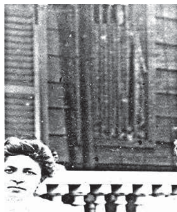
雨樋とその影、縦格子窓に注目
