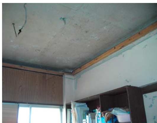
写真2 天井の吹付けひる石（学生寮）
