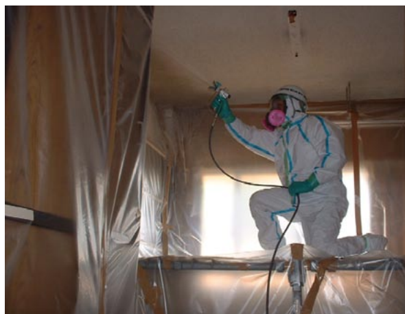
写真62 石綿撤去作業
