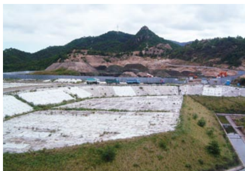
写真30 香川県豊島の不法投棄現場
