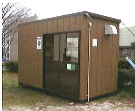
写真28 設置した喫煙ハウス
