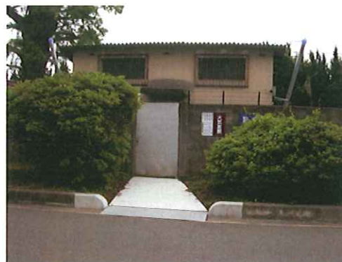
写真44 改修後の危険物薬品倉庫
