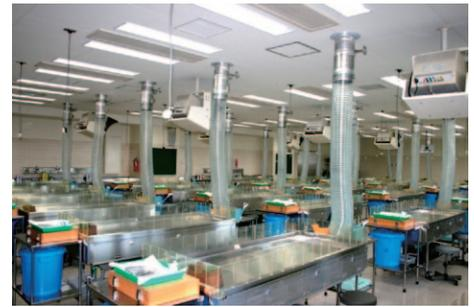
写真19 局所排気装置付実習台
