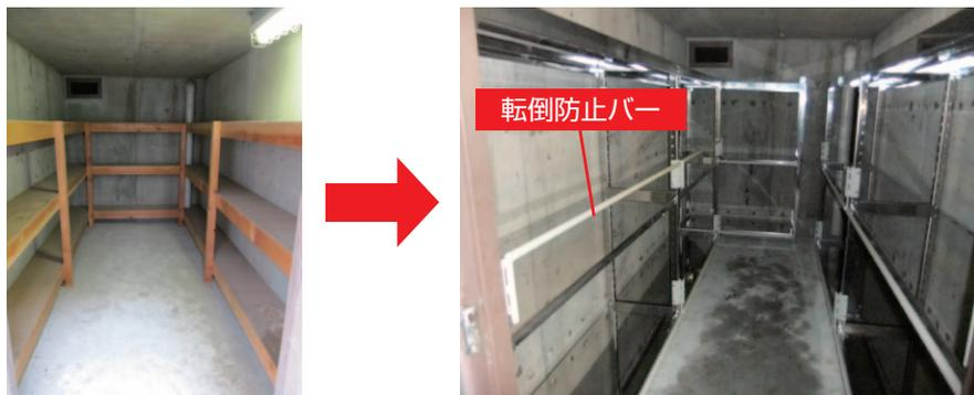
危険物貯蔵所内の木製棚をステンレス棚へ変更し、転倒防止バーを設置
