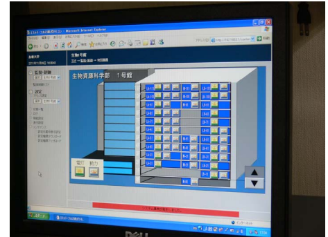
電力モニタリングシステム画面
