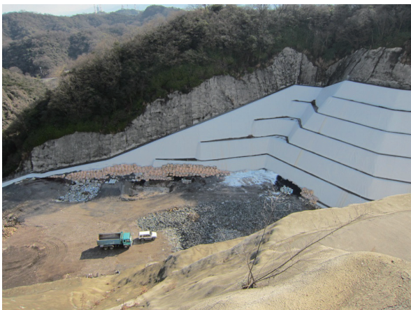
愛媛県西条市船尾の山間にある最終処分場。
