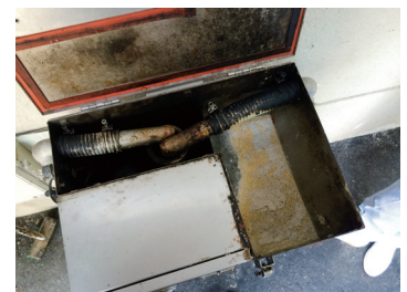
グリสบキューマシステムで 油分処理をする様子
