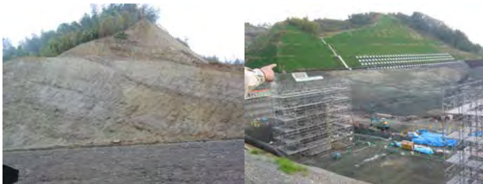
写真1.1.6 斐伊川放水路開削部の施工 流れ盤となる南側斜面では大規模なアンカー施工による対策工がなされている。
