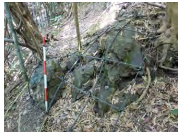
写真1.2.94 ロープ伏工(ロープネット工)
