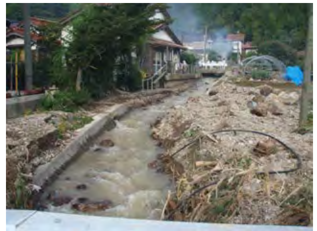
写真 1.2.2 平成 19 年 8 月豪雨による谷川下流域の被災状況
