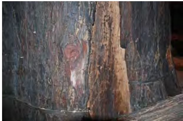
写真3.3.21 三瓶小豆原埋没林の立木に見られる土石流の痕跡 樹木表面の成長異常部は、岩石が衝突し立木は損傷を受けたが、その後も成長していたことを物語っている。このような傷跡が一つの立木に何か所か見られることから、大規模な土石流は立木が埋没する以前にも何回もあったと推定される。
