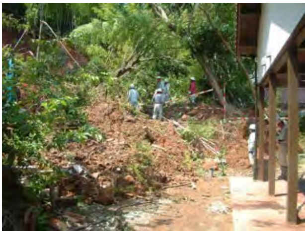
写真 1.2.23 崩積土と被災した建物写真
