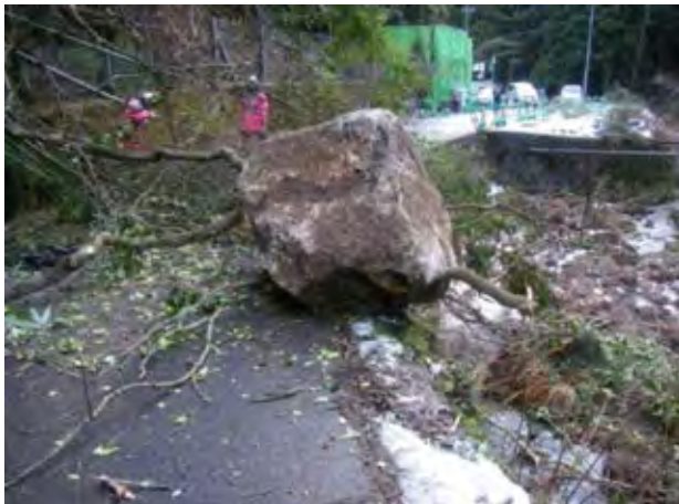
写真 1.2.89 平成 21 年 1 月 29 日に発生した落石 落石の直径は約 1.2 m。
