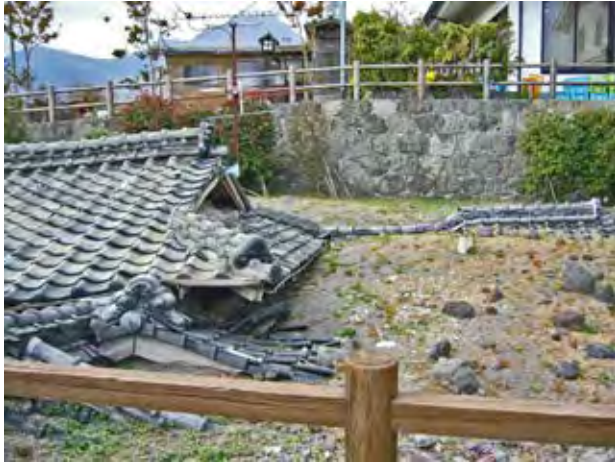
写真3.3.11 水無川沿いの土石流被害 島原市深江町，土石流被災家屋保存公園。
