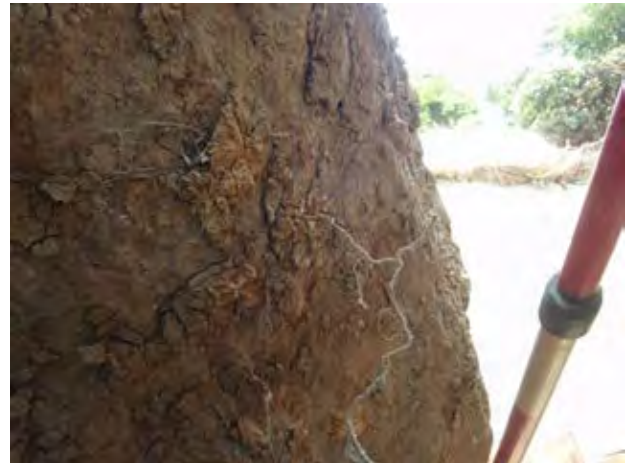
写真1.2.65 落下巨大岩塊観察 (亀裂に付着した粘土)
