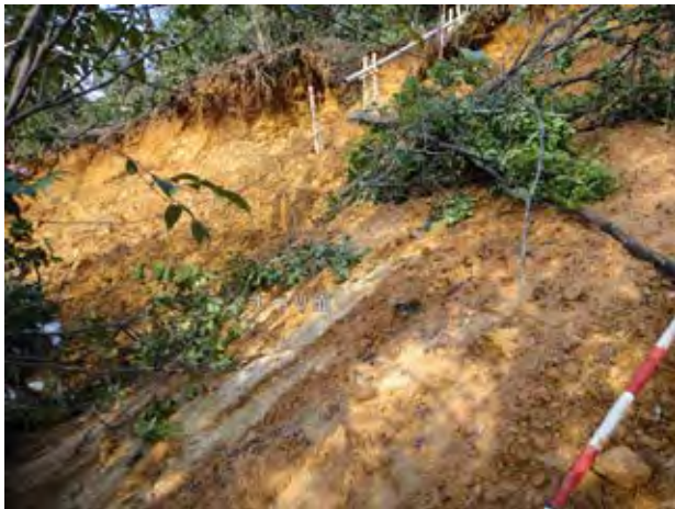
写真1.2.56 露頭したすべり面
