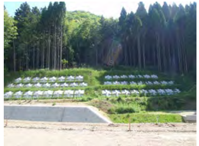
写真1.2.84 河川付替え工事竣工後の状況
