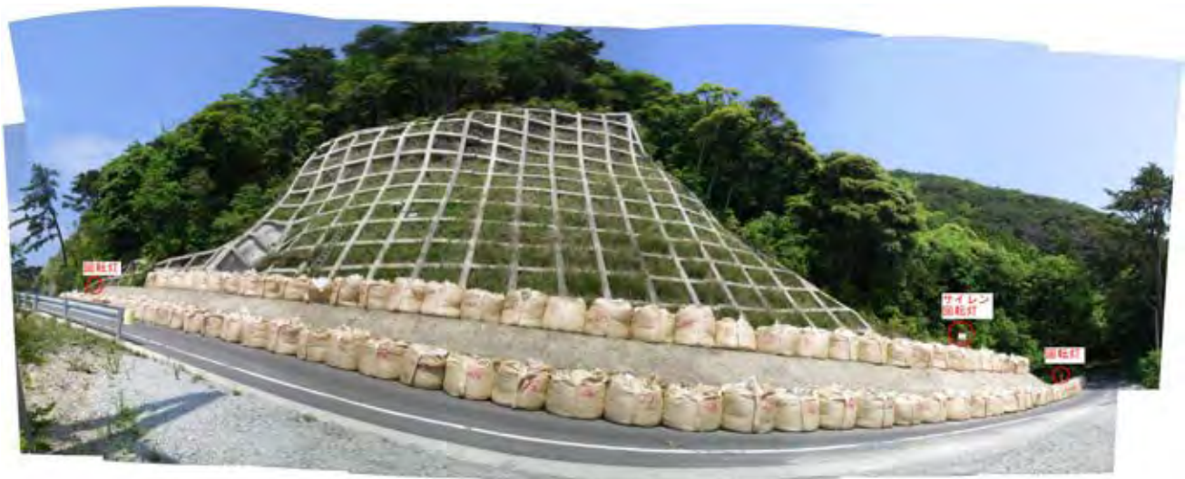
写真 1.2.45 応急押え盛土の施工後全景
