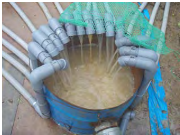
写真 1.2.76 上段ボーリング暗渠工の排水状況
