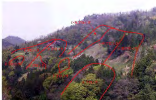
写真1.2.42 地すべり地の全景写真 A～Cブロックが上段ブロック群, D～Gブロックが下段ブロック群。
