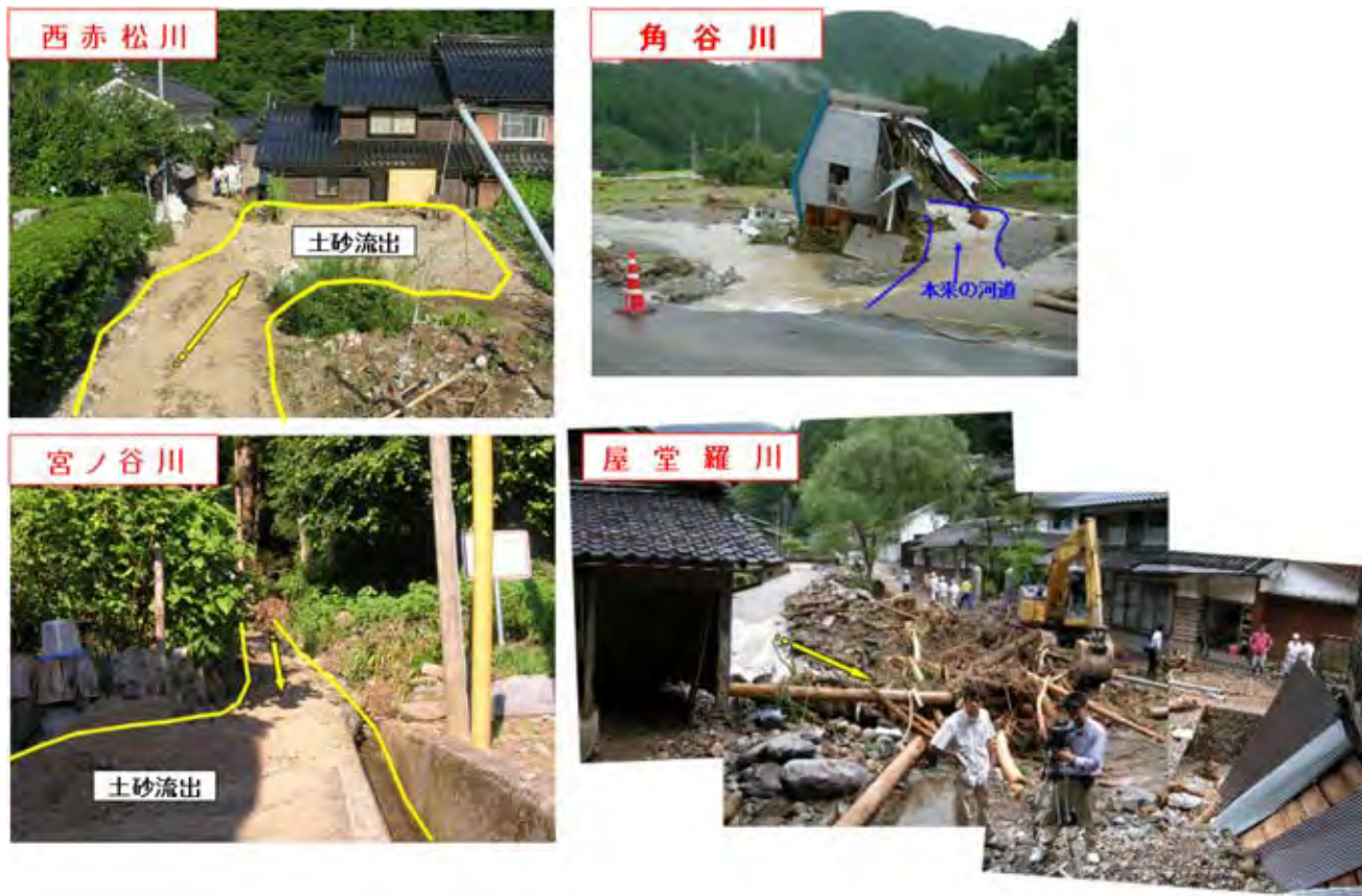
写真2.3.11 被災状況の写真
