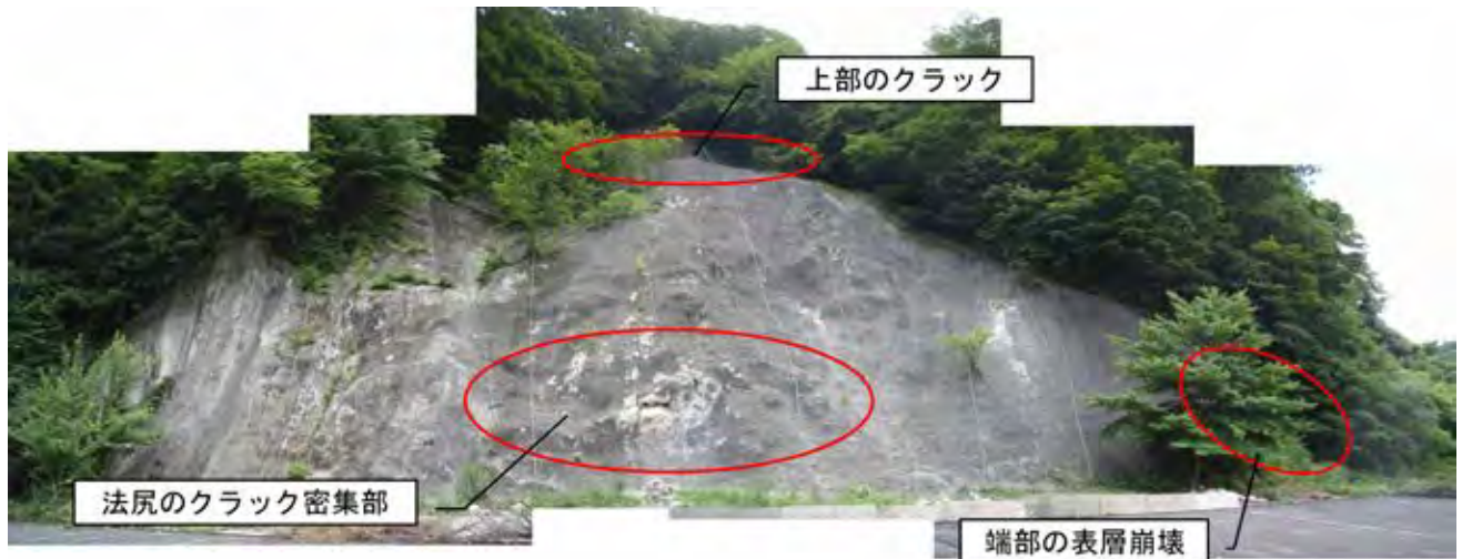
写真1.2.30 のり面の全景
