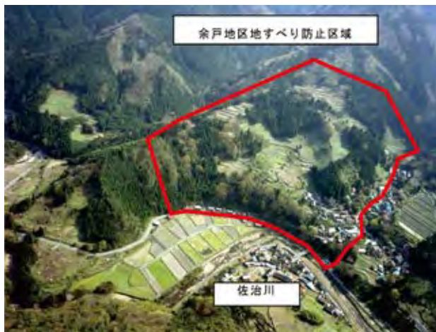
写真2.3.18 余戸地区地すべり防止区域 全景写真
