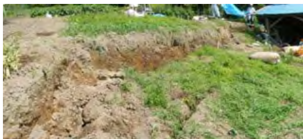
写真 1.2.75 頭部滑落段差の状況
