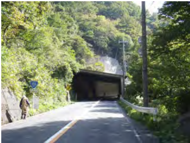
写真1.2.38 スノーシェッドと道路のり面
