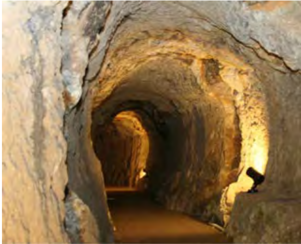
写真 1.2.88 龍源寺間歩孔内の様子
