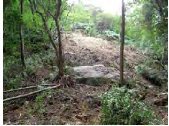
写真1.2.52 トンネル口上の溪流右岸に発生した表層崩壊
