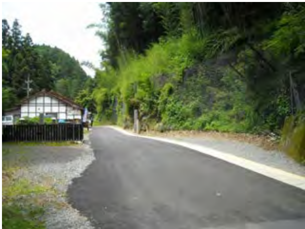
写真1.2.96 見学道路沿いの落石防護網工 龍源寺間歩手前 500 m。
