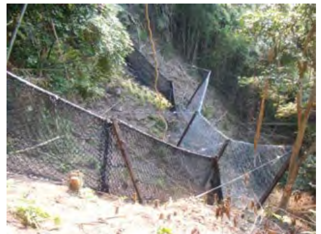
写真1.2.95 高エネルギー吸収タイプの落石防護柵工
