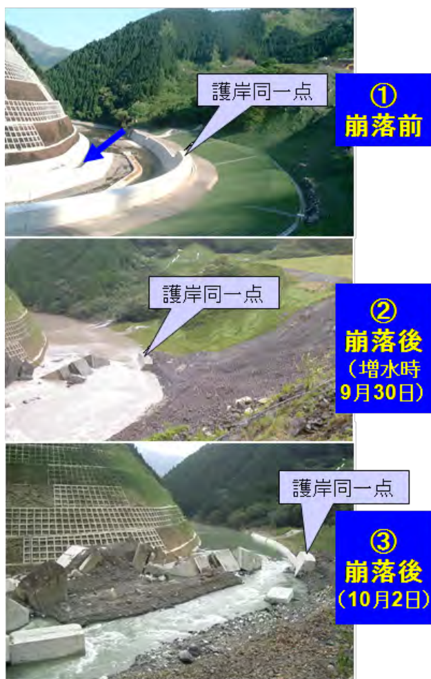
写真2.3.16 崩落前後状況写真
