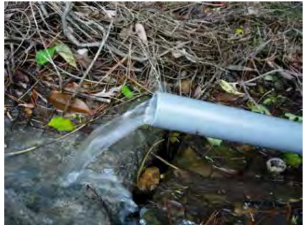
写真1.2.80 応急横ボーリング工排水状況(流末)
