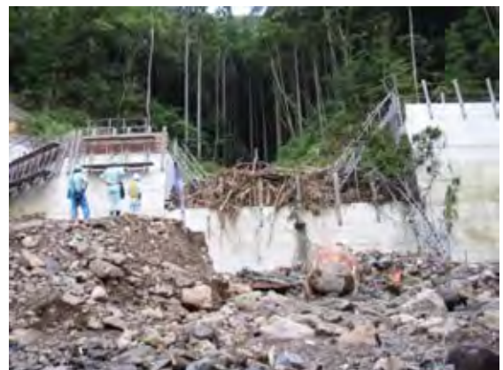
写真1.2.50 大津久における左支溪施工中の砂防堰堤の状況
