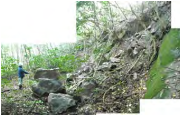
写真1.2.20 斜面上位の造成面で発生した崩壊 仙ノ山西側の栃畑谷出口付近。
