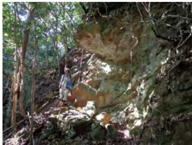
写真1.2.16 斜面中腹の造成面ののり面にある浮石 オーバーハングで非常に不安定。大森地区の斜面中腹。
