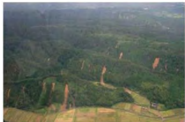
写真2.3.6 中村地区の被災状況(鳥取県林業試験場撮影)
