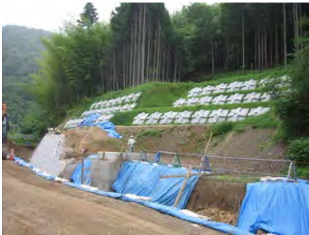
写真1.2.83 アンカー施工状況
