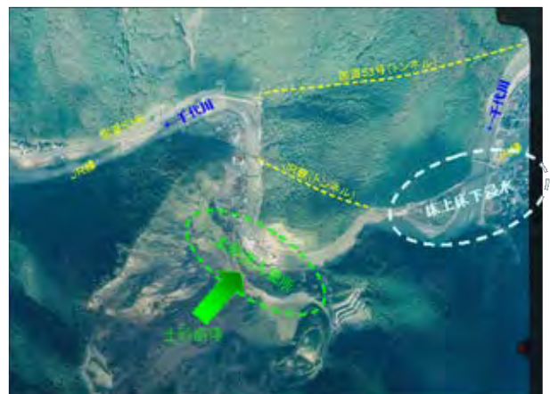
写真2.3.14 被害状況写真
