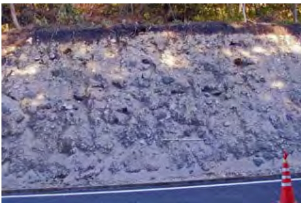
写真3.3.16 図3.3.18のD地点の露頭写真
