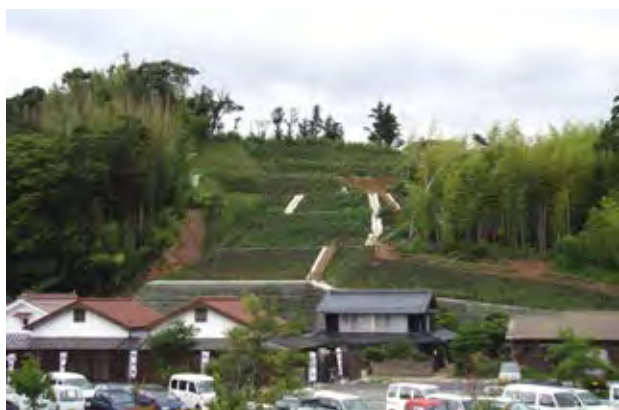
写真1.2.28 対策斜面の全景
