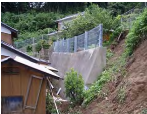
写真1.2.54 土砂をとめた擁壁 (西ノ島町浦郷小浦地区)
