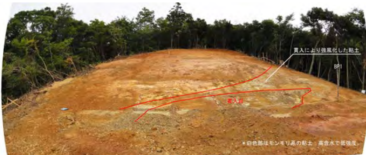
写真1.2.60 背後斜面の貫入岩
