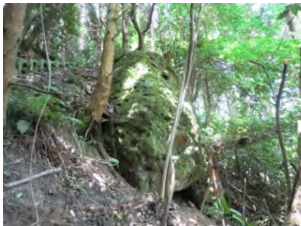
写真1.2.15 直径4mにおよぶ凝灰角礫岩の浮石 下部はほぼ空洞。要害山南西側の斜面中腹。
