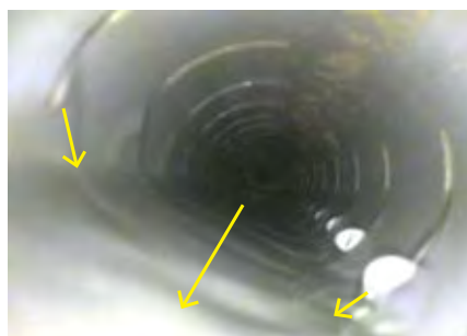
写真 1.2.71 孔内の湧水状況 (スリット)
