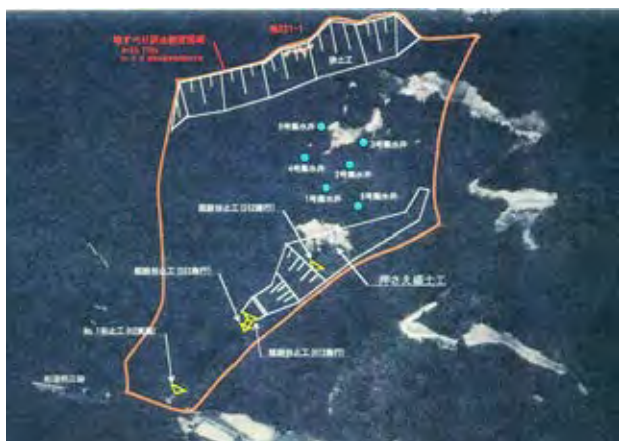
写真2.3.17 明辺地区地すべり防止事業全景航空写真
