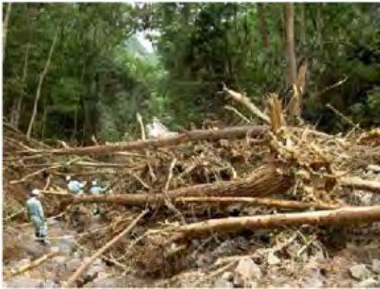
写真1.2.51 トンネル口上の溪流出口に堆積する流木群
