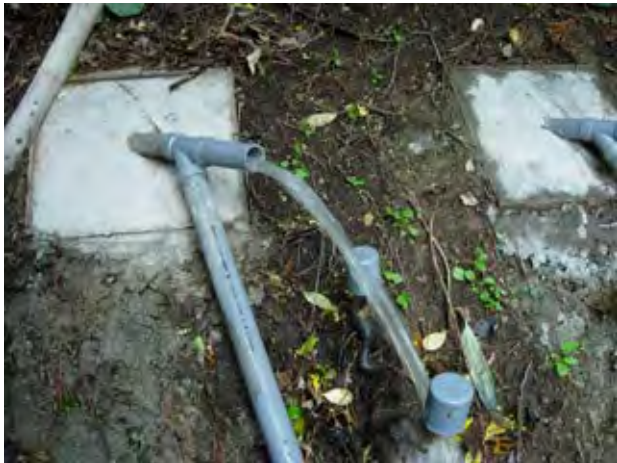
写真1.2.79 応急横ボーリング工排水状況(孔口)
