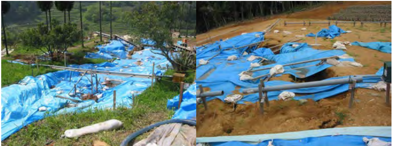
写真1.1.1 県内各地で頻繁に発生する小規模な地すべり
