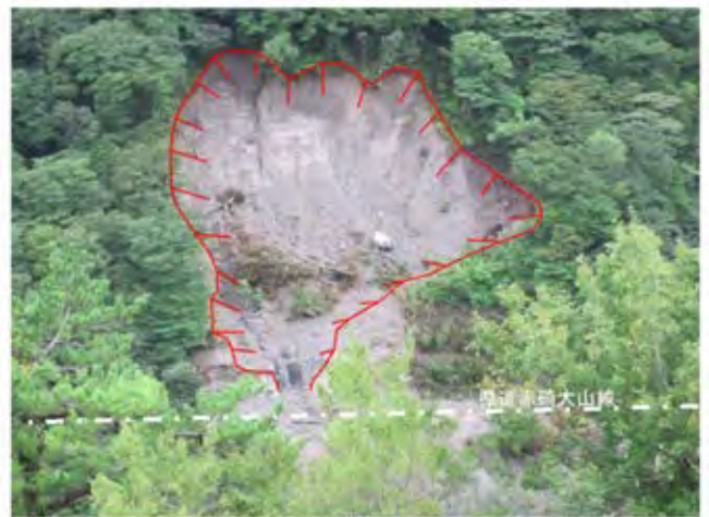
写真2.3.1 崩壊斜面の全景
