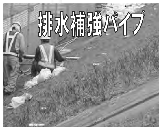
簡易な法面崩壊防止対策
