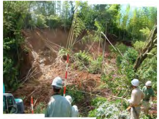
写真 1.2.22 末端崩壊の状況
