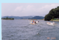
光ファイバケーブルの敷設
