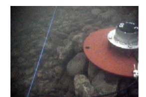
川床に設置した光ファイバケーブル(左)とオンライン音響動態観測システム用送受波器(右)
