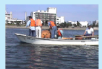
光ファイバケーブルの敷設
