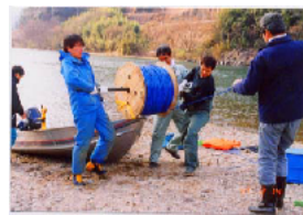
光ファイバケーブルの設置準備
