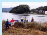
マルチセンサの敷設作業
