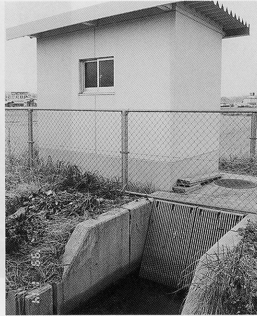
1.3 揖屋干拓地タメ池への送水用ポンプ場
