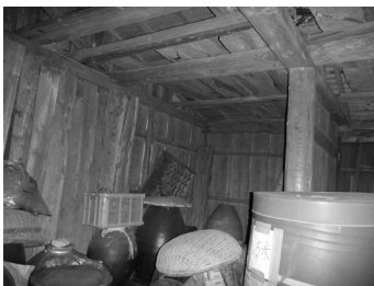
写真-3 板倉 No. 6 室内部の仕切り
