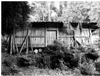
写真-8 板倉 No. 3 外観
