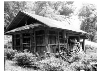
写真-7 板倉 No. 2 外観
