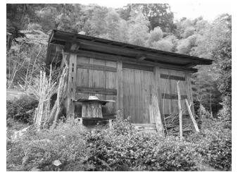
写真-11 板倉 No. 6 外観
