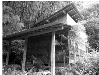
写真-10 板倉 No. 5 外観
