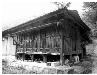
写真-6 板倉 No. 1 外観
