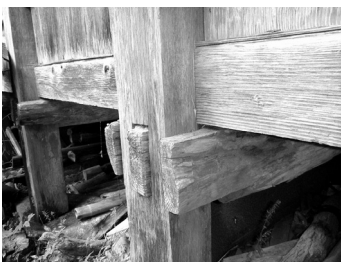
写真-5 板倉 No. 5 足固めの輪薙柄の仕口
