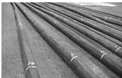
図11 溶接位置に印を付けた状態
