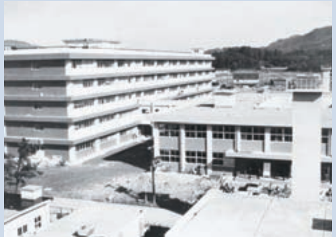
竣工時の農学部本館・南棟(昭和42年)
