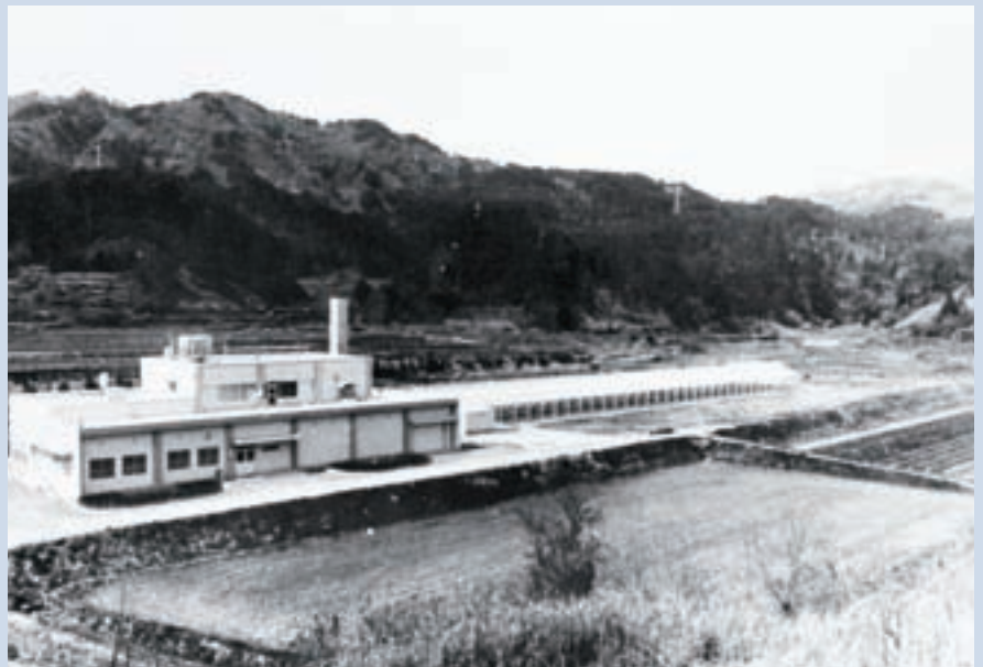
本庄農場のコンピューター制御システム化施設(昭和49年7月)
