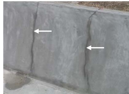
図-1 既往の補修材料の早期ひび割れ
