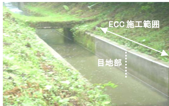
写真-4 試験施工写真
