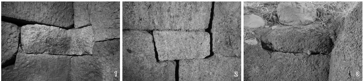
第 51 図 山陰の導入期切石造横穴式石室にみる切組積み (1. 古天神古墳玄室 2. 上塩冶築山古墳玄室 3. 福岡岩屋古墳前室)
